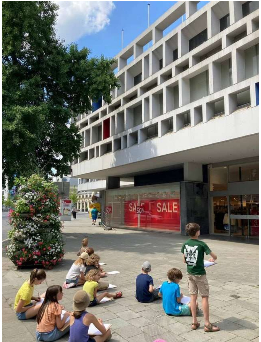
Stage de sensibilisation à l'architecture moderniste organisé du 4 au 8 juillet 2022 par l'ICA-WB en réaction à l'annonce de la démolition du bâtiment C&A. ©ICA-WB, 2022.
