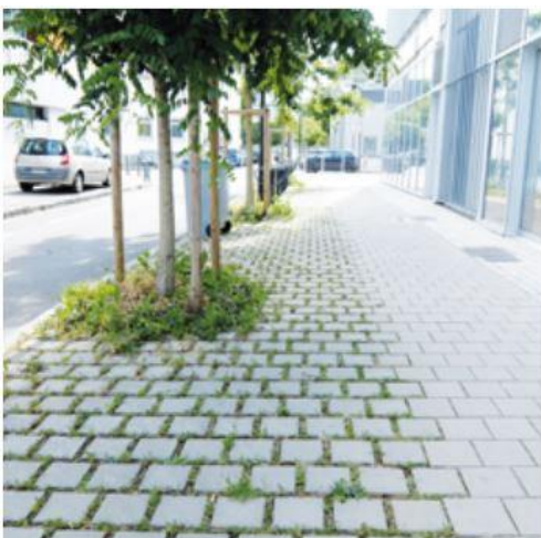
Figure 5 : joints végétalisés, matériaux drainants ou joints drainants permettent de capter et infiltrer jusqu'à 80% de l'eau de pluie.
