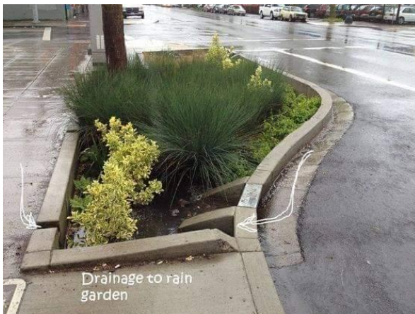
Figure 6 : une partie de l'eau de pluie est dirigée et stockée vers les zones de plantation.
