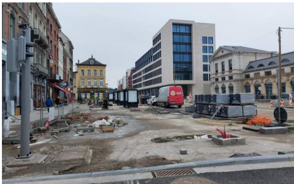
Figure 1 : premiers travaux, une débauche de béton.
