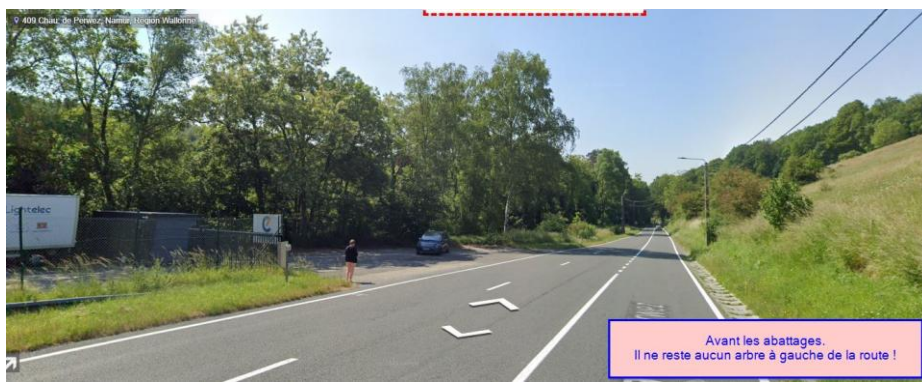
Figure 2: vue de la chaussée de Perwez avant les abattages.
